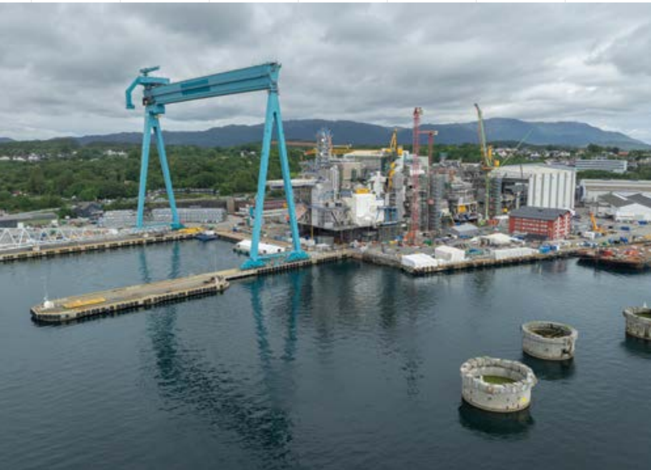
Bygging av Hugin A og Valhall PWP på Stord. Foto: Aker Solutions
