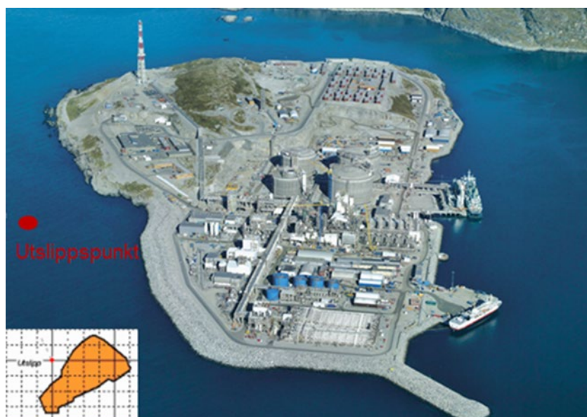
Figur 1. Hammerfest LNG og utslippspunkt for produsert vann. Utslippspunkt fra vannrenseanlegg 130 m fra land på 30 m dyp.
