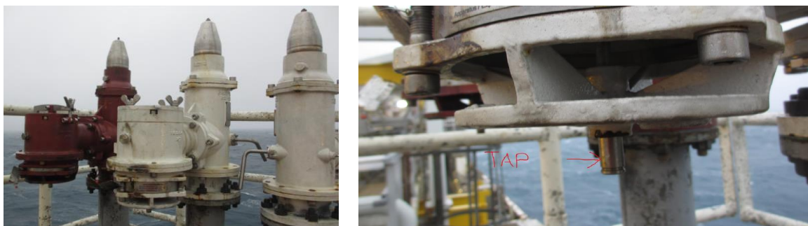
Figur 1 Venstre side: Trykk/vakuum-ventiler (PVVer). Høyre side: Tap (full stroke check lift) som vurderes modifisert.
