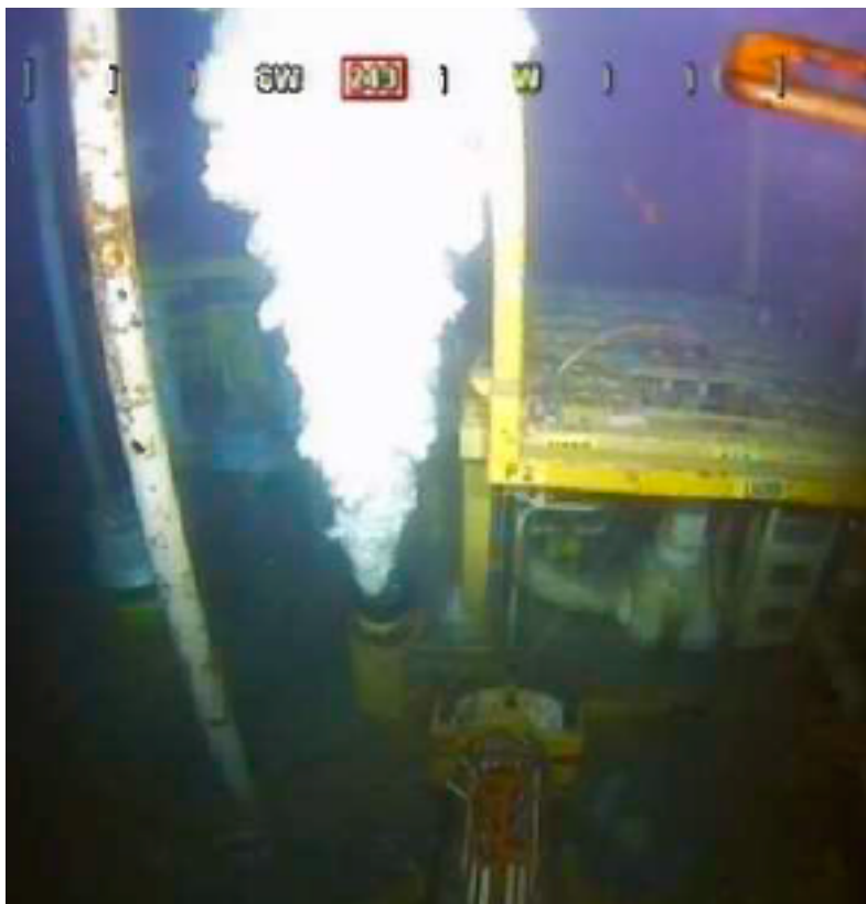
Figur 1 - Bilde av gasslekkasje (Kilde: Statoil)
