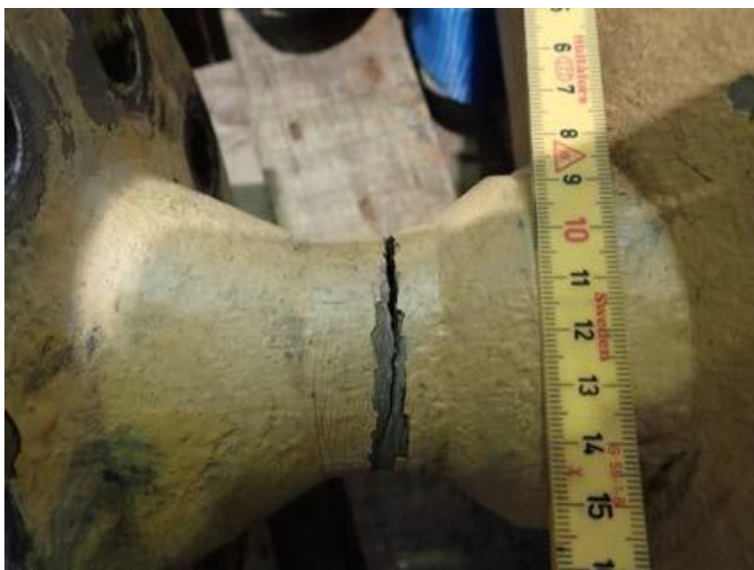
Figur 4: Bruddet (Foto fra Statoils materialtekniske undersøkelse)
