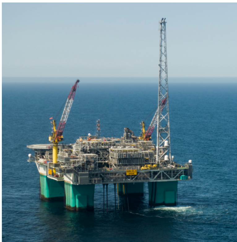
Figur 6 - Gjøa innretningen. Bilde tilhører Engie E&P.
