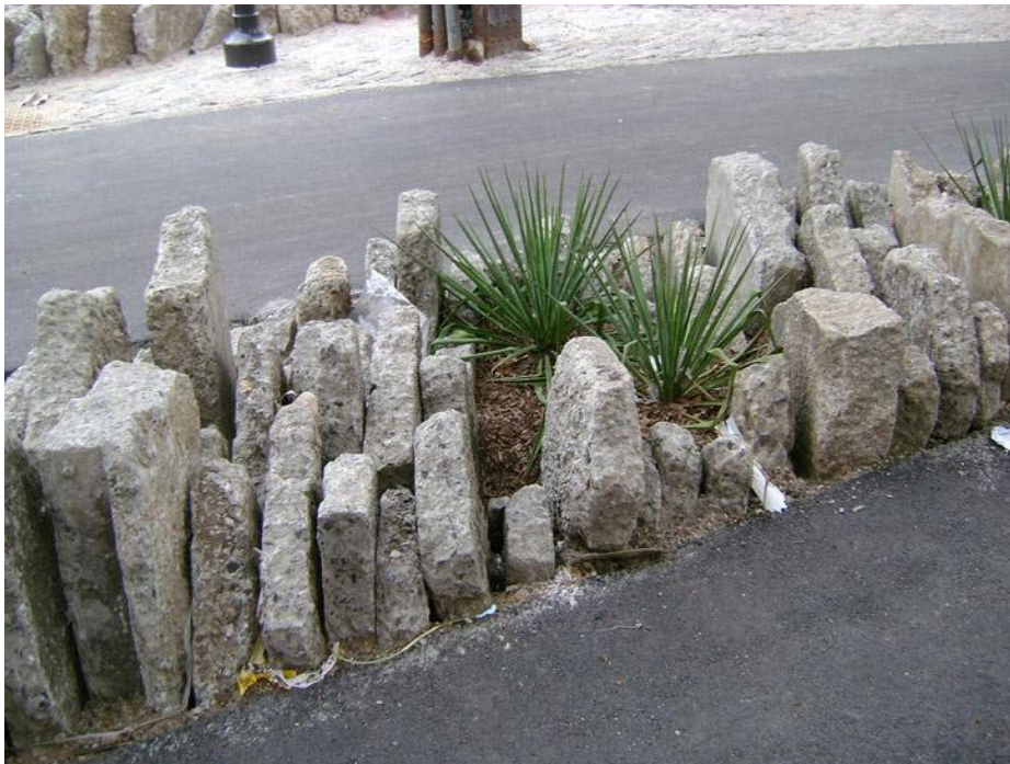
Figur 13. På Queensboro Plaza i New York har man brukt betongbiter til å lage trafikkøyer og skille forskjellige trafikkanter. Kilde: http://inhabitat.com/nyc/jagged-chunks-of-sidewalk-reused-to-create-unique-median-for-queens-plaza/comment-page-1/
