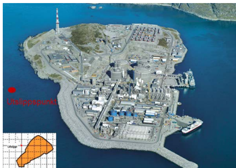
Figur 10.1 Utslippspunkt fra vannrenseanlegg på Melkøya 130 m fra land på 30 m dyp
