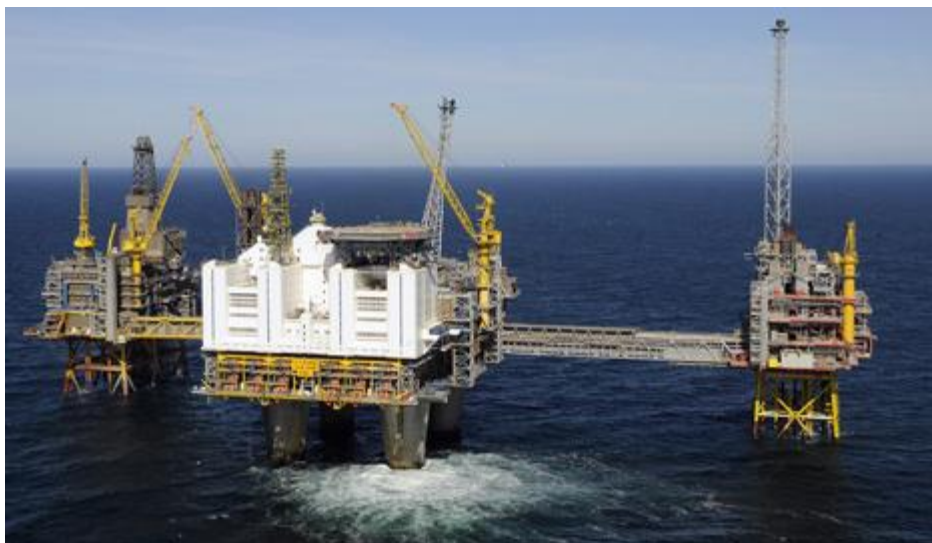
Figur 1 Oseberg feltcenter, kilde Statoil.no
