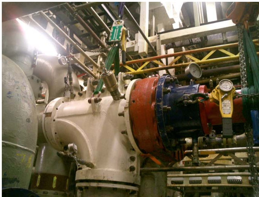
Fig 4.3 - Hot-tap maskin med sagen koblet opp
