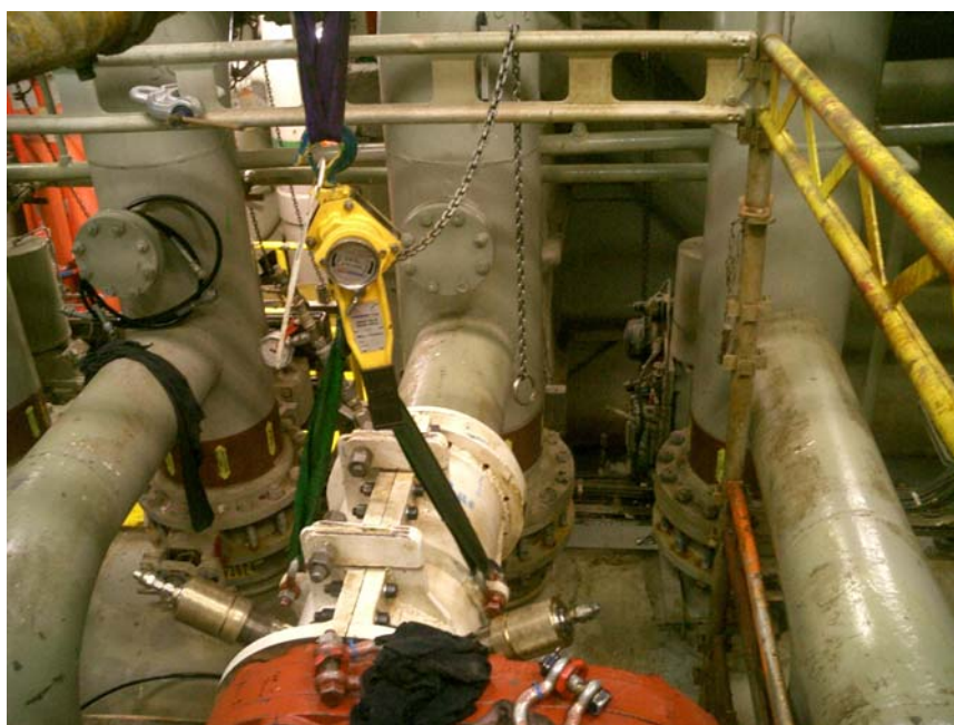
Fig 4.2 - Hot-tap maskin oppkoblet – sagstøttene ses på hver side, manifold og rørføring til cellene ses i bakgrunnen
