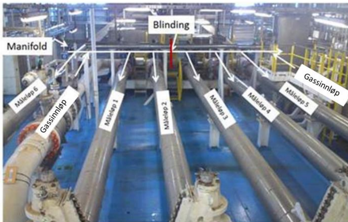
Figur: Målepakke med manifold øverst. Sted hvor blindingen ble satt er vist med rød vertikal strek og gasstrømmene inn i måleløpene er vist med hvite piler. Lekkasjested var til høyre for rød strek.
