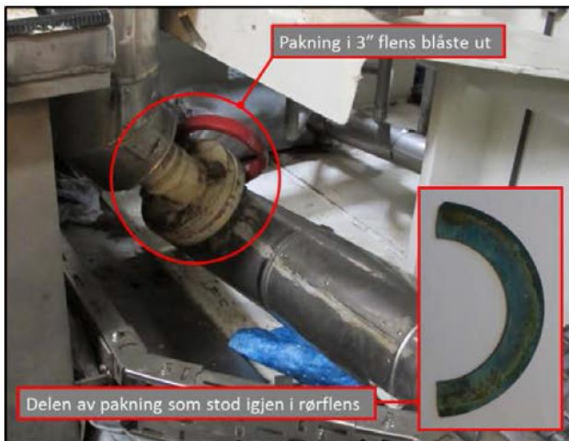
Figur: Rød ring indikerer hvor pakningen i 3" flens blåste ut
