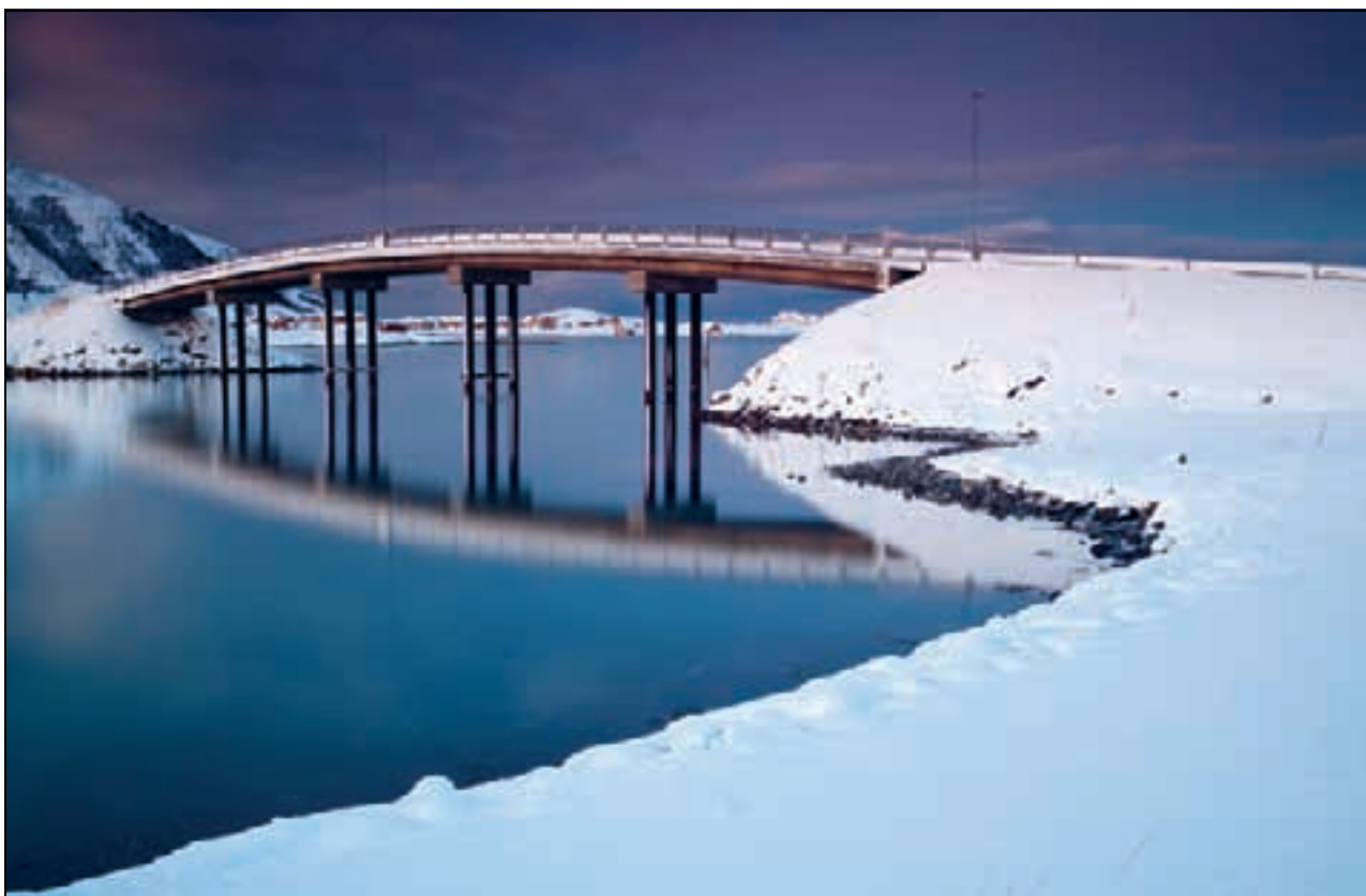
Figur 2.1 Bro mellom Sommarøy og Hillesøy i Troms.
