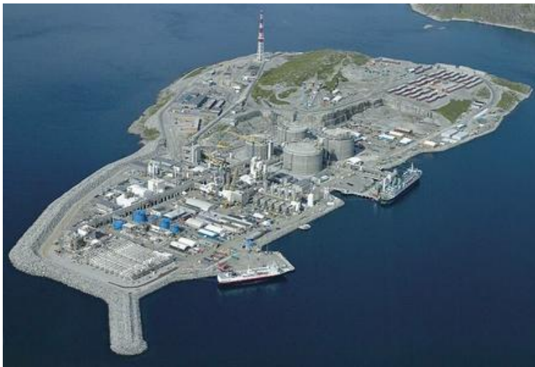
Figur 33 Melkøya-anlegget for mottak og prosessering av naturgass fra Snøhvitfeltet i Barentshavet. Bilde: Norsk petroleum.
